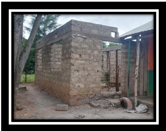
Das neue Administrationsgebäude an der GBA nimmt langsam Gestalt an.
