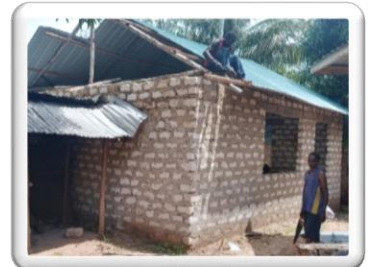
Die neue Schulküche nimmt Form an.
