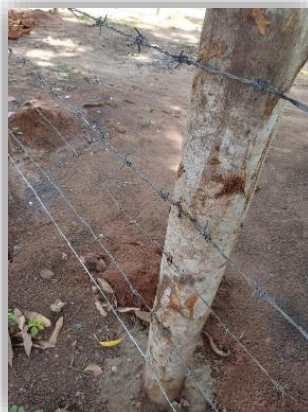
Der Zaun wird ausgebessert.
