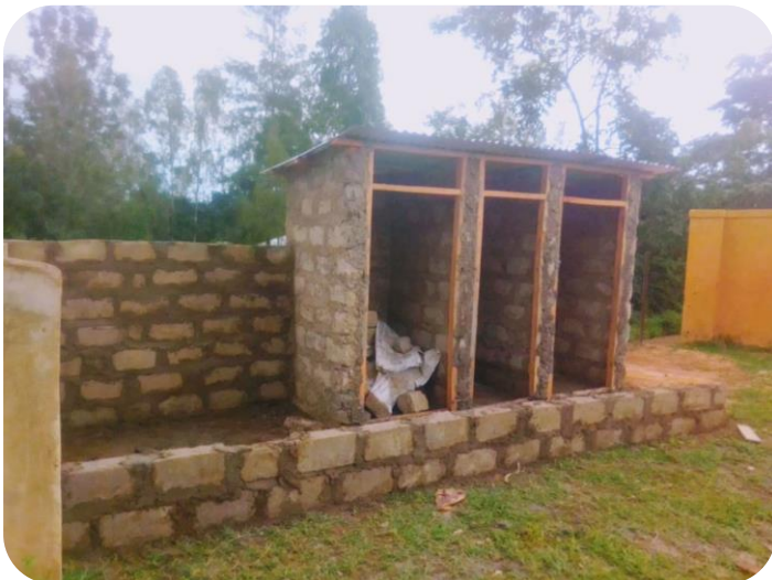
Toilettenbau an der GBA
