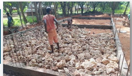
Die Steine fürs Fundament werden gelegt.
