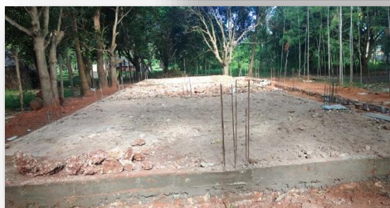
Das Fundament der Secondary-Klassenräume steht.
