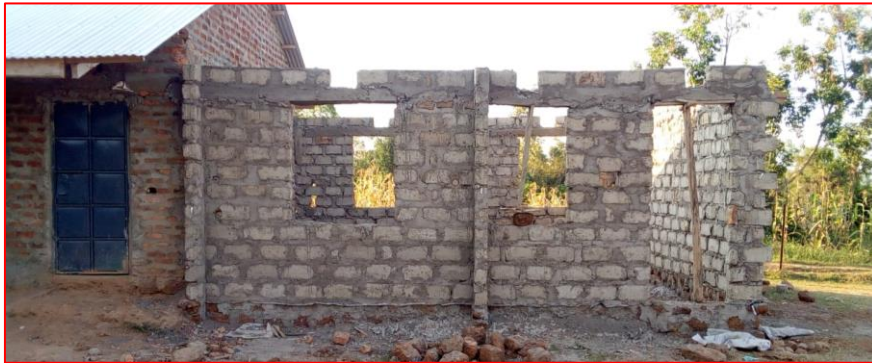
Der Bau des neuen Klassenraums für die GBA schreitet voran.
