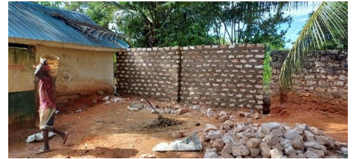
Schulmauer um die GGA vervollständigt
